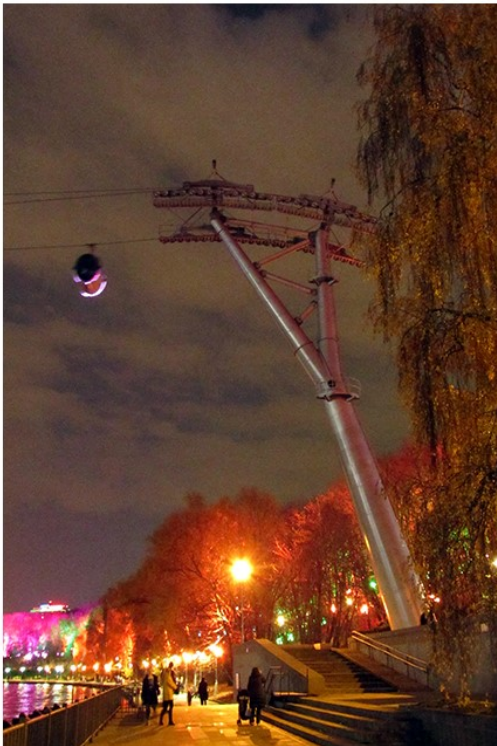
5–6. Опора канатной и вагончик дороги
