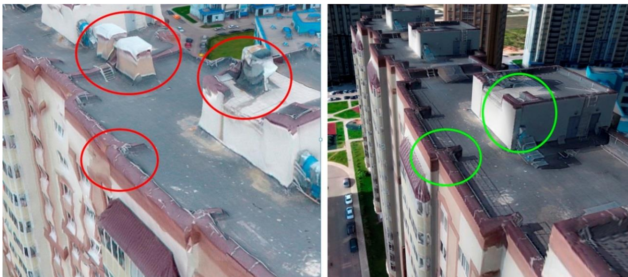
Рис. 5. Искажение форм зданий на бесструктурной модели (слева) и правильное отображение этих же элементов в структурной модели (справа) Fig. 5. Distortion of building forms on a model without structural lines (left) and the correct representation of the same elements in a structural model (right)
