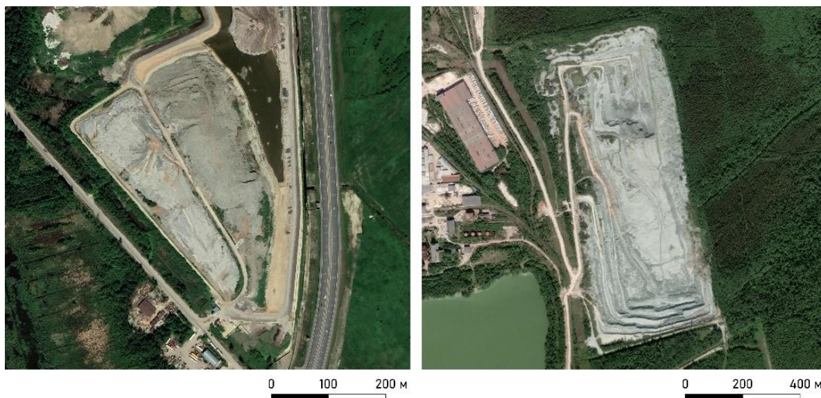
Рис. 1. Рекультивируемый полигон твердых бытовых отходов — слева, и разработка месторождения глины — справа. Снимки доступны в Google Earth™ Fig. 1. A recultivated landfill — on the left, and the clay opencast — on the right. The images are available on Google Earth™
