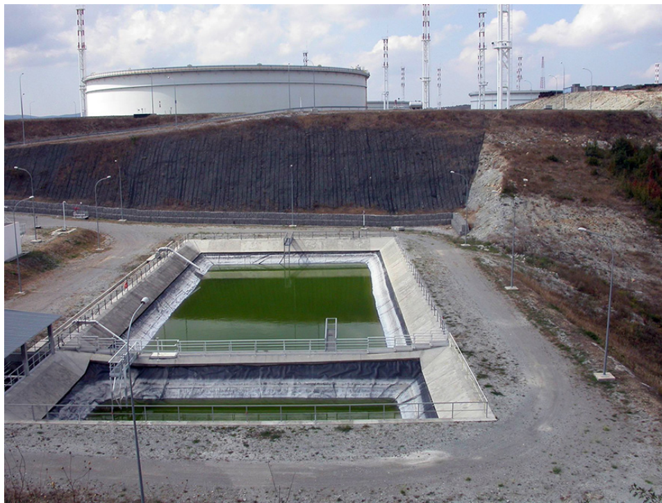
Рис. 3. Техногенные формы рельефа (склоны с инженерной защитой) и инженерные объекты (противопожарный водоем)
