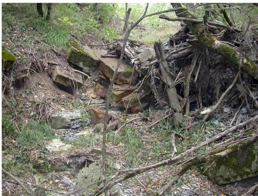
Рис. 9. Древесно-каменная селевая плотина в днище долины Fig. 9. Wooden-stone debris flow dam at the valley bottom
