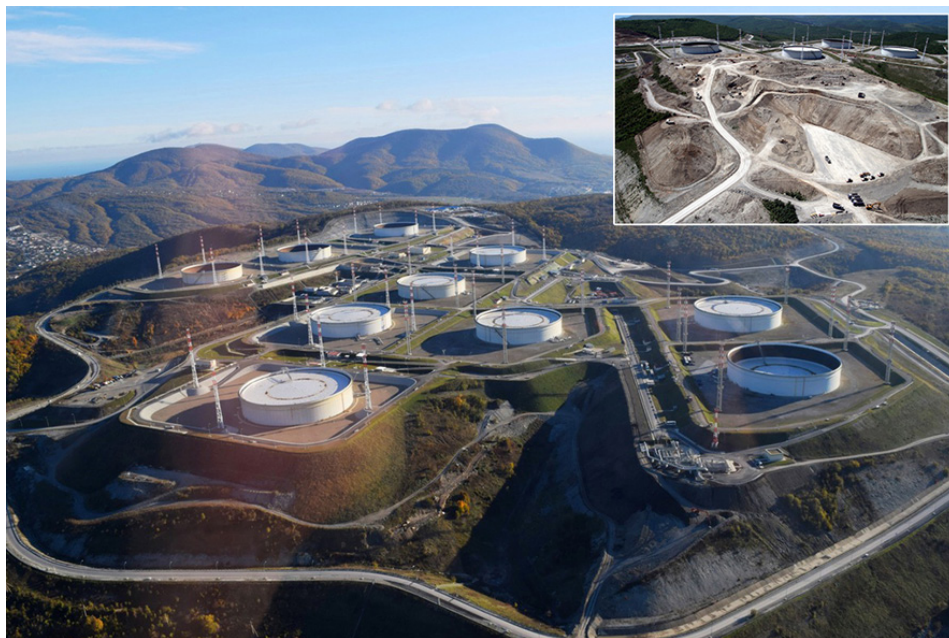
Рис. 1. Общий вид резервуарного парка магистрального трубопровода (на врезке, начало строительства)
