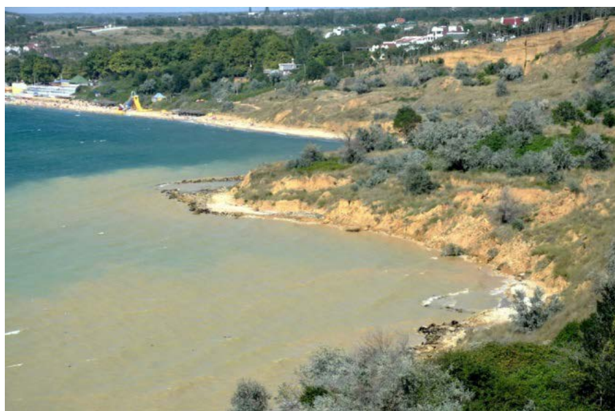
Рис. 8. Визуальная фиксация последствий проявления оползня 2019 г.
