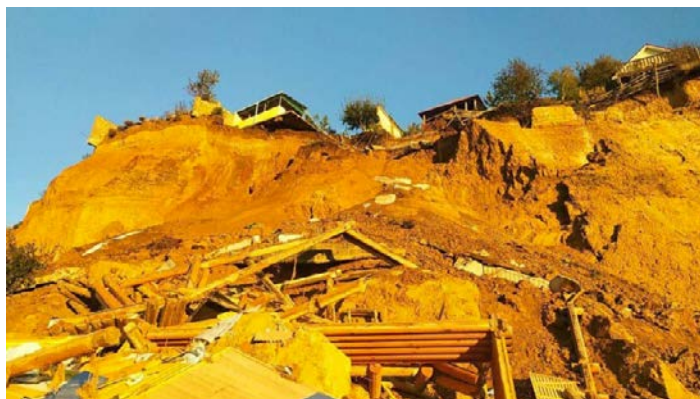
Рис. 5. Последствия проявления одного из оползней Севастопольского региона Fig. 5. Consequences of the manifestation of one of the landslides of the Sevastopol region
