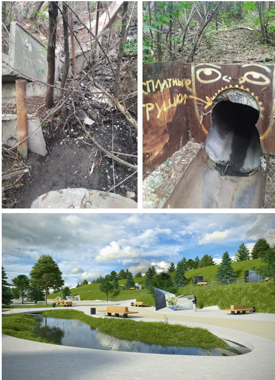
Рис. 4. Пример возможной трансформации водосборной системы. 4а) современное состояние; 4б) преобразование в структуре паркового хозяйства
