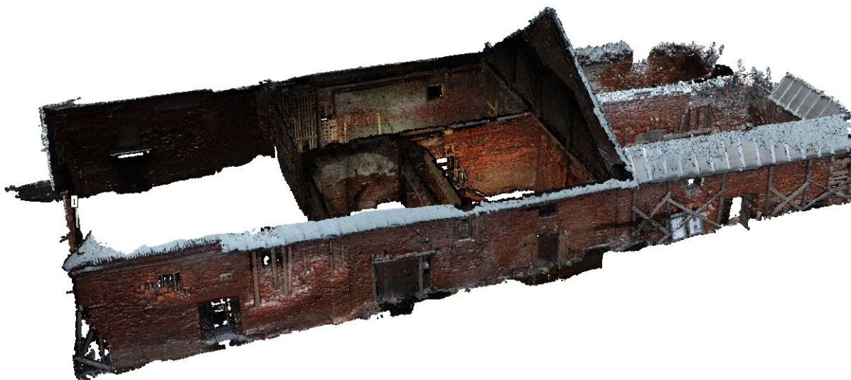
Рис. 4. Финальная модель амбара в виде облака точек Fig. 4. The final barn model is in the form of a point cloud
