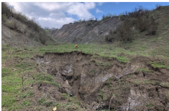
Рис. 9. Вторичный эрозионный врез в оползневую массу на конусе выноса. Белгатой, апрель 2022 г. (фото Р. А. Гакаева) Fig. 9. Secondary erosion incision into the landslide mass on the alluvial fan. Belgatoy, April 2022 (photo by R. A. Gakaev)
