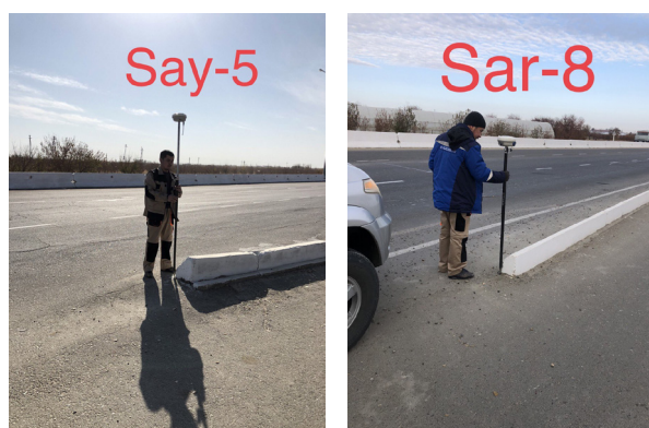
Рис. 7. Выбор опорных точек Fig. 7. Selecting ground control points (GCPs)
